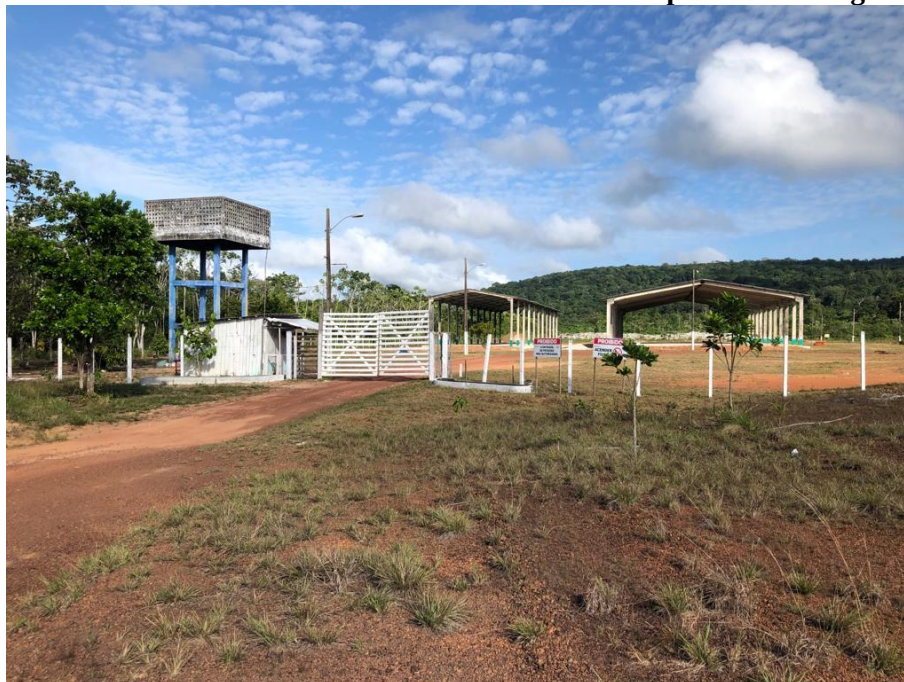
Figura 32 - Portão na entrada do aterro sanitário do Município de Tartarugalzinho.
