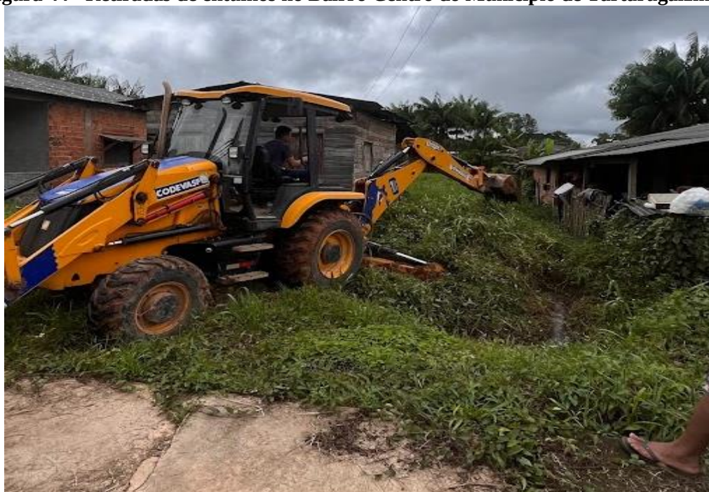
Figura 44 - Retiradas de entulhos no Bairro Centro do Município de Tartarugalzinho.
