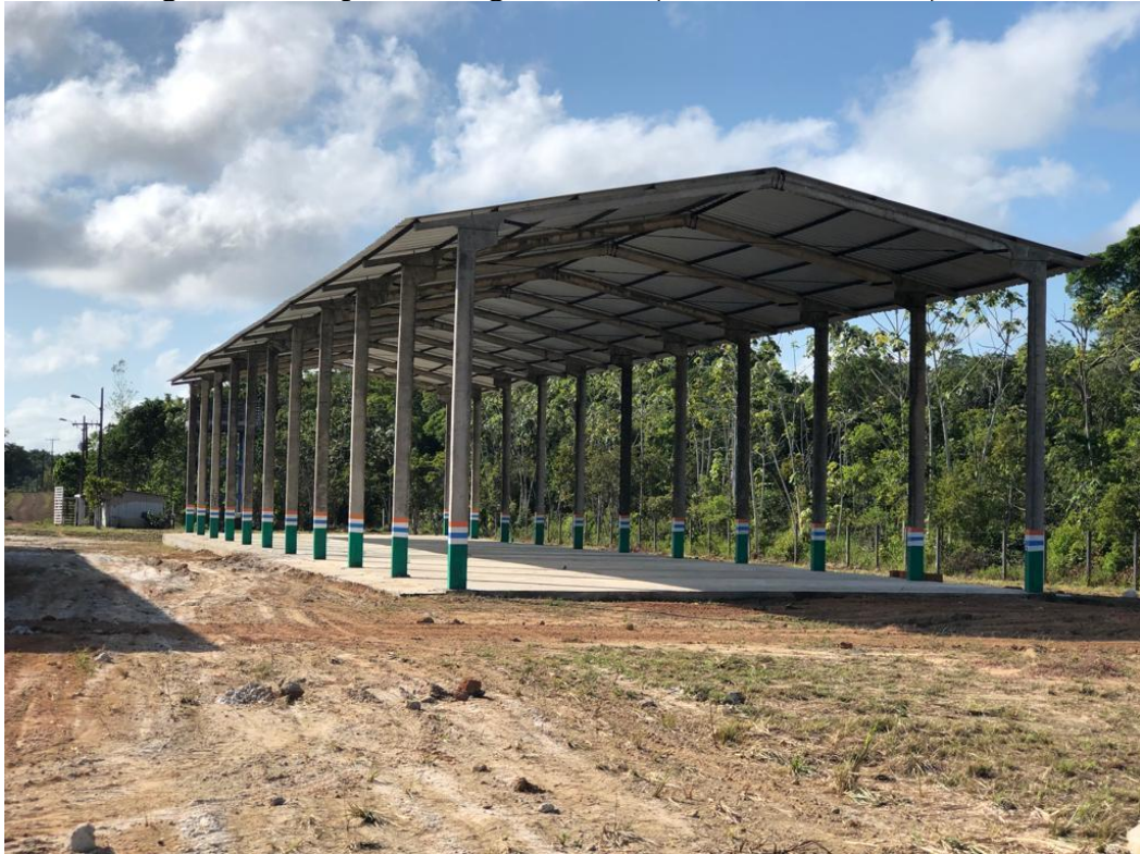
Figura 25 - Galpão de triagem menor (dimensão 600,00 m 2 ).
