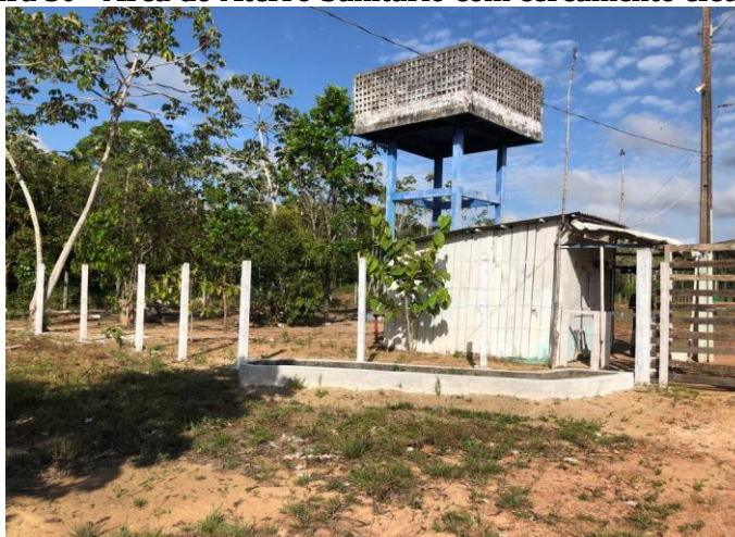
Figura 30 - Área do Aterro Sanitário com cercamento efetivo.
