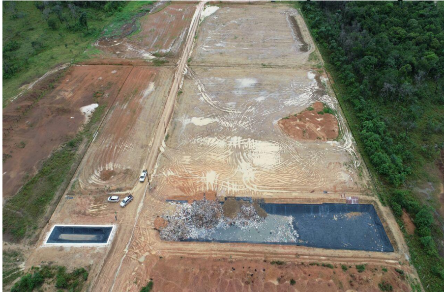
Figura 28 - Foto aérea do Aterro Sanitário do Município de Tartarugalzinho-AP.
