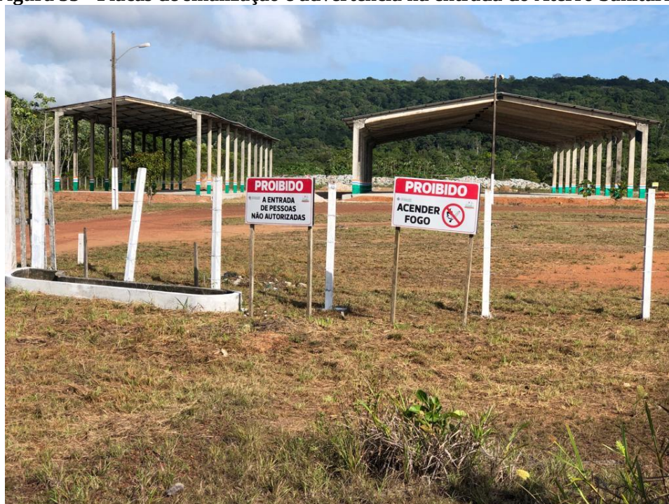
Figura 33 - Placas de sinalização e advertência na entrada do Aterro Sanitário.
